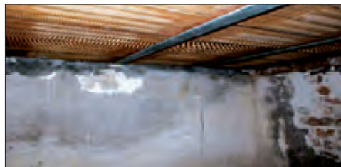
Solaio in putrelle e tavelloni
