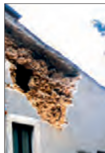
Fig. 3.1 – Pc: sezione a paramenti ben collegati o ad unico paramento (sezione piena)
